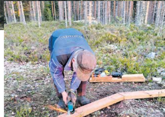
Luontokirkon alttari tuotiin paikalle kolmessa lohkossa ja kiinnitettiin kallioon porattuun jalustaan.
